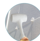
4 - Battere sullo spinotto per ottenere l'espansione
