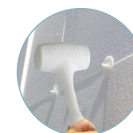
4 - Battere sullo spinotto per ottenere l'espansione
