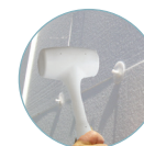
4 - Battere sullo spinotto per ottenere l'espansione
